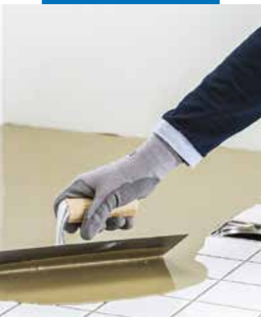
Påføring af Planex HR med pudsebræt af metal
